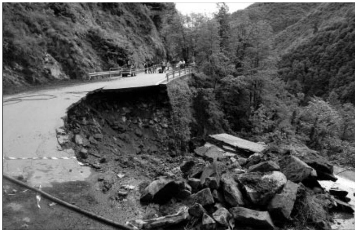
Ieri ruspe in azione lungo la 549 per mettere in sicurezza il passaggio pedonale ai bordi della frana
